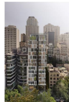
MARYAM RESIDENCE ساختمان مسکونی مریم - الهیه تهران - گروه سغی - ۱۳۹۹ (مدیر پروژه : راضیه شعاعی)
