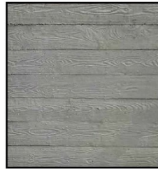
بتن مسلح درجاریز با قالب بندی چوبی
