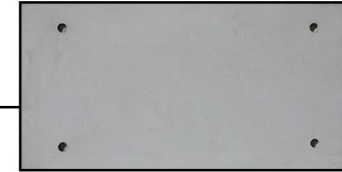
پنل طرح بتن اکسیوز اجرا به صورت خشک
