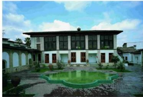
نمونه عمارت دوره قاجار در شمال با فرم صلب در همکف و نیمه شفاف در طبقه اول و سقف شیبدار
