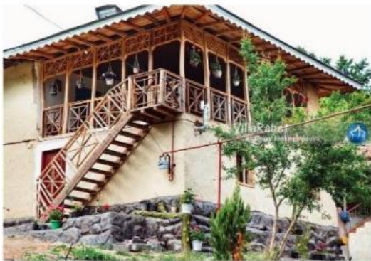
نمونه خانه سنتی در شمال با فرم صلب در همکف و نیمه شفاف در طبقه اول و سقف شیبدار
