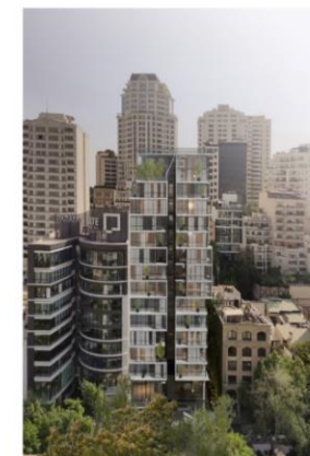
MARYAM RESIDENCE ساختمان مسکونی مریم - الهیه تهران - گروه سفی - ۱۳۹۹ (مدیر پروژه : راضیه شعاعی)
