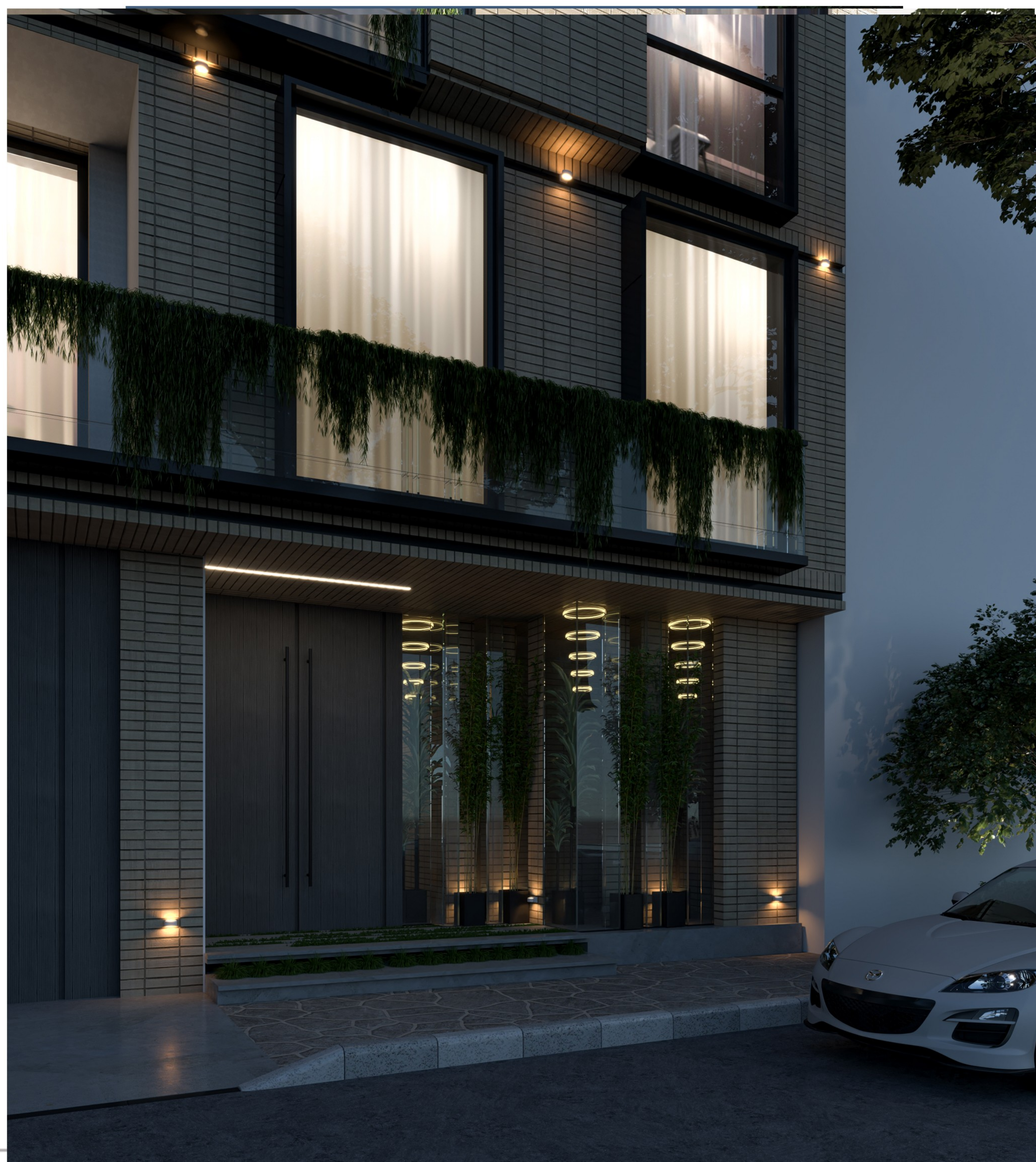
رندر شب از جزئیات نمای شمالی [نمای اصلی]
