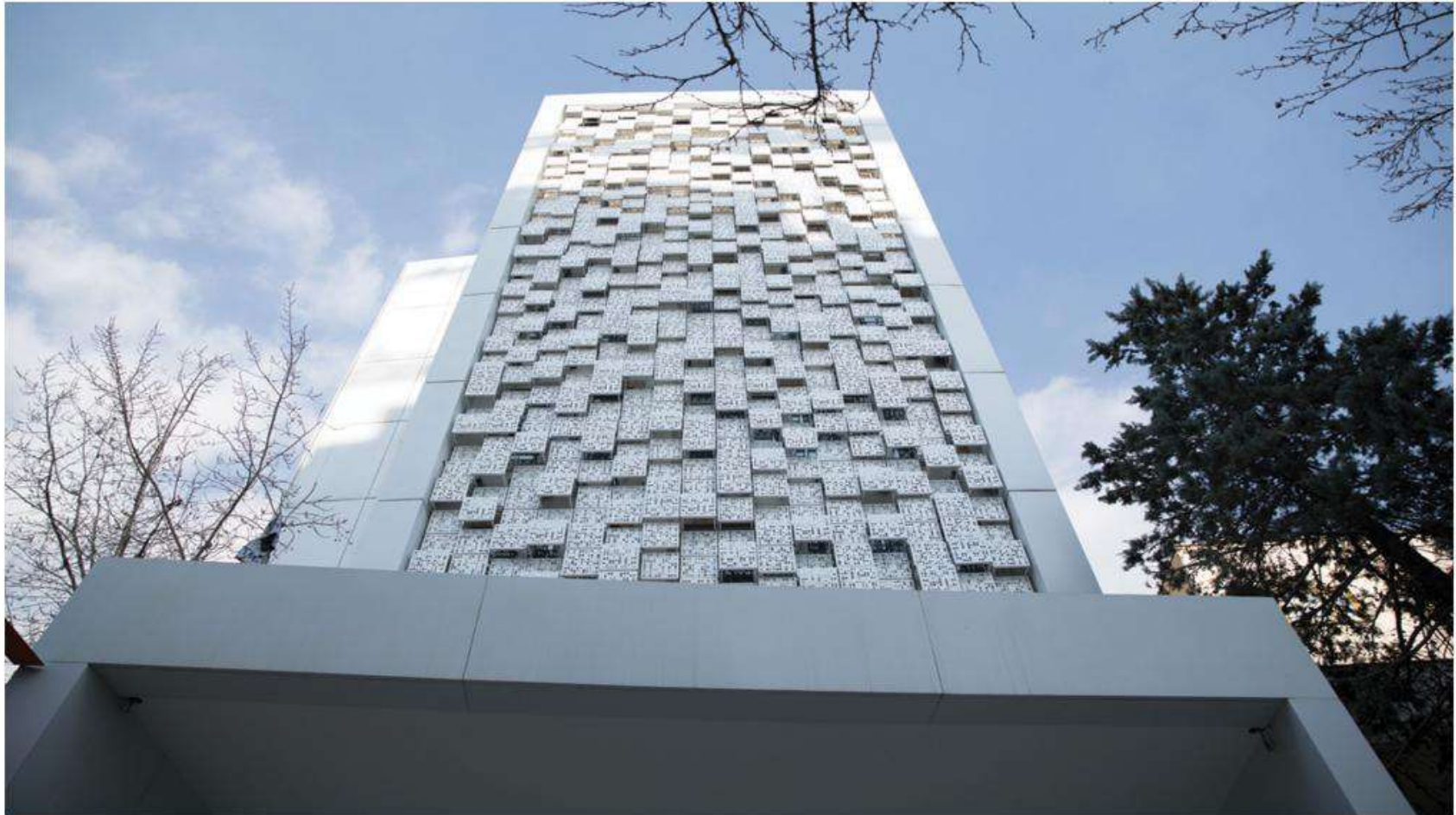
ساختمان چینه نیوران / تهران اتمام ساخت و بهره برداری : ۱۳۹۹
