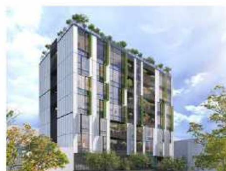
SHIRIN RESIDENCE مجتمع مسکونی شیرین - ولنجک - تهران - بخش خصوصی - ۱۴۰۰ - در حال ساخت
