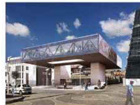
AP OFFICIAL BUILDING ساختمان اداری آسان پرداخت - پردیس تهران - گروه آپ - ۱۳۹۶ (مدیر پروژه : محسن رضایی)
