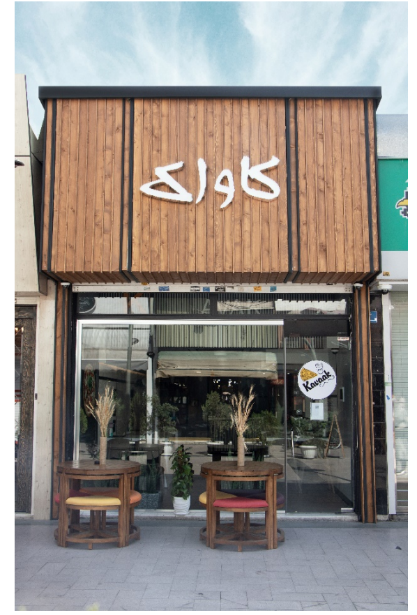
بعد از اجرا
