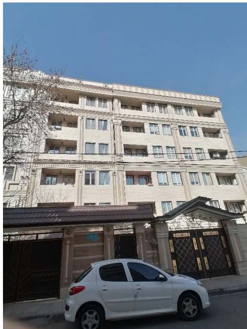
تصویر نمای اصلی ساختمان مجاور چپی 1
