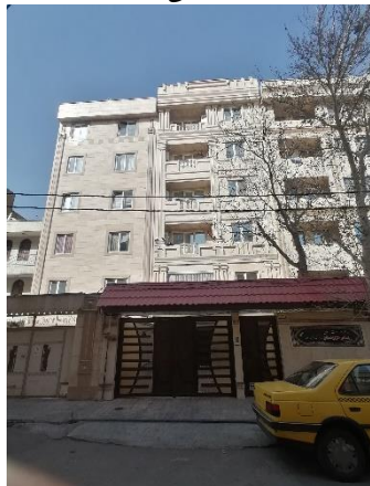
تصویر نمای اصلی ساختمان مجاور چپی 2
