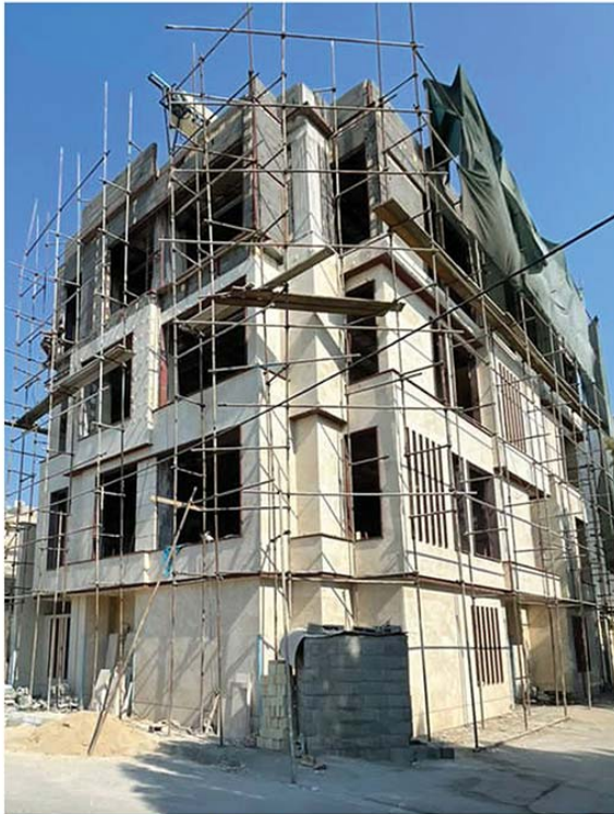
وضعیت پروژه در حال اجرا
